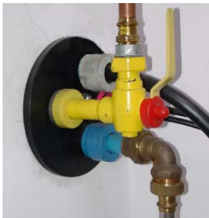
Beispiel: Mehrsparten Hauseinführung
