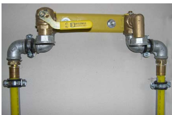
Gas-Zähleranschlussplatte – Anschluss mit nicht metallenen Leitungen
