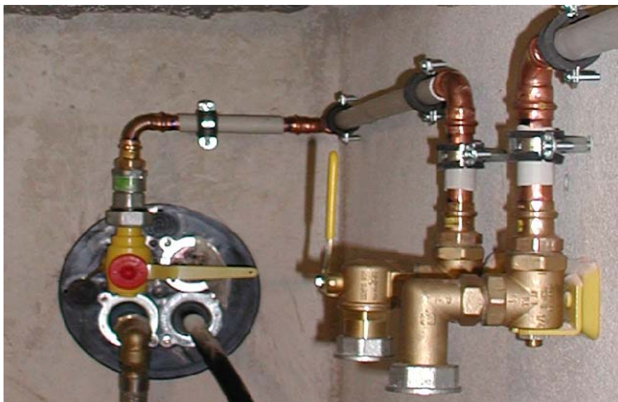
Anschluss einer Gaszähler-Anschlussplatte
