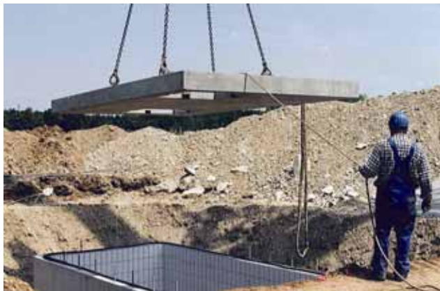
Wasserwerk an der Forsthausstraße 2001: Brunnen 5 wird in die Erde eingelassen
