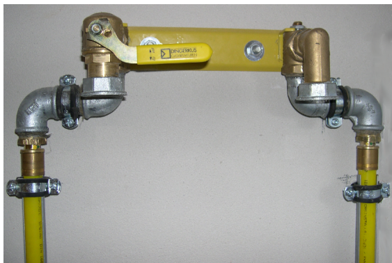
Gas-Zähleranschlussplatte – Anschluss mit nicht metallenen Leitungen
