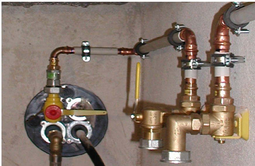
Anschluss einer Gaszähler-Anschlussplatte
