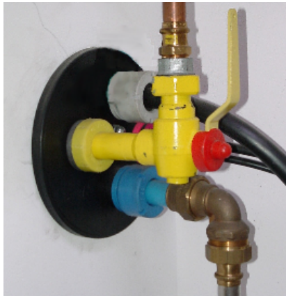
Beispiel: Mehrsparten Hauseinführung
